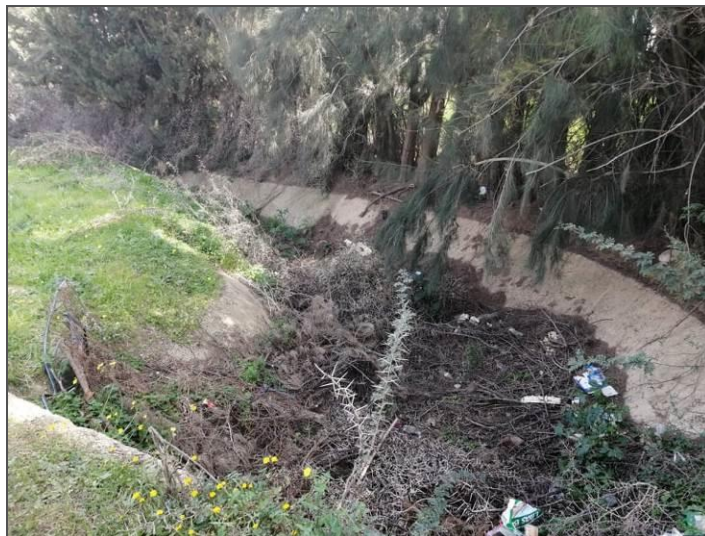
Photo 10 : Canal de drainage.
