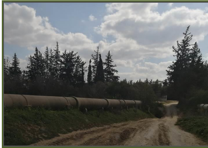
Photo 6 : Conduites de distribution.
