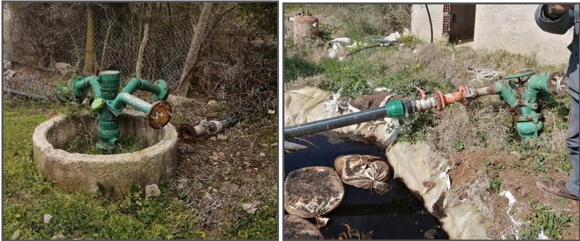
Photo 8 : Borne d'irrigation à 4 prises.
