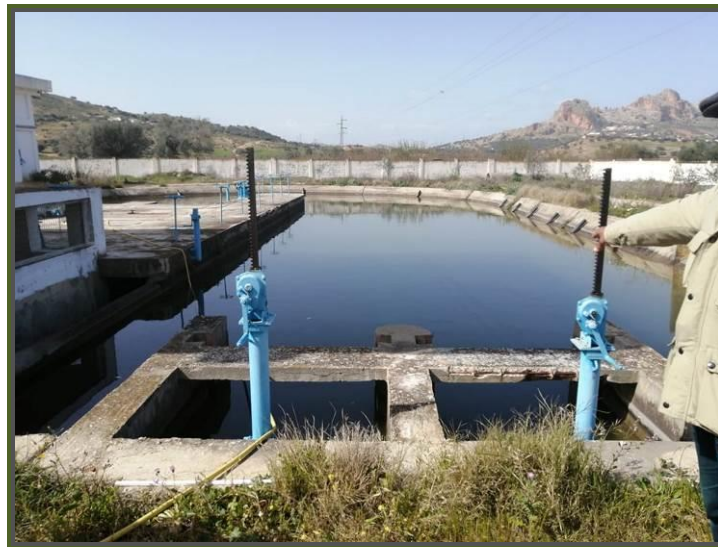
Photo 4 : Canal de décantation.
