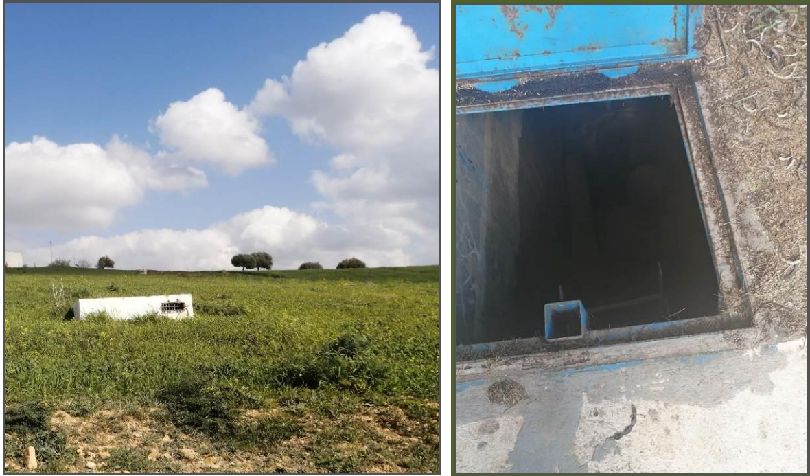
Photo 7 : Ouvrage de sectionnement.
