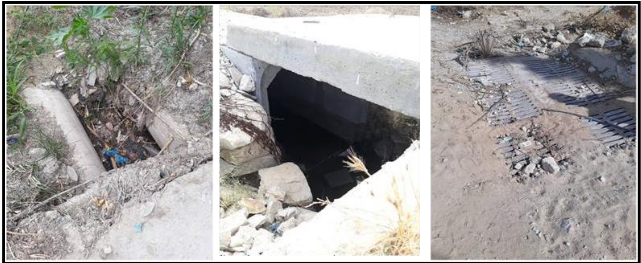
Figure 2: Curage et entretien des regards et des fossés
