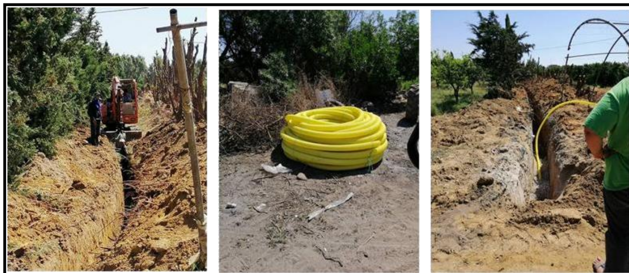
Figure 5: Fossés et conduites de drainage
