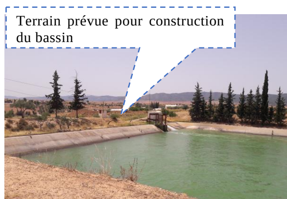
Photo n° 2 : Réservoir de Sidi Ayed
