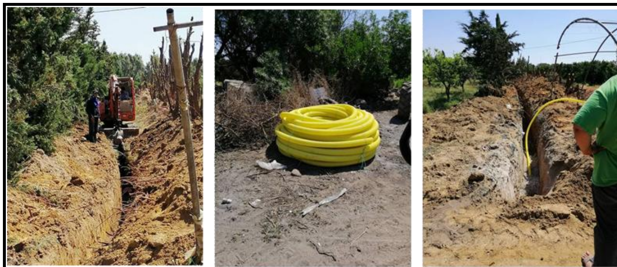
Figure 2: Fossés et conduites de drainage
