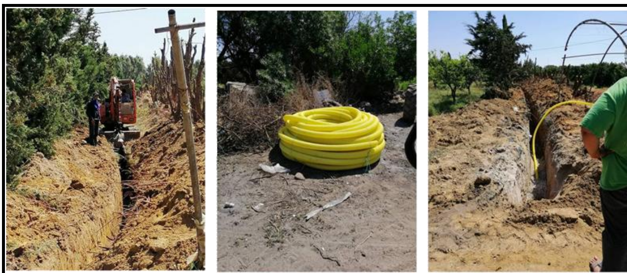
Figure 2: Fossés et conduites de drainage
